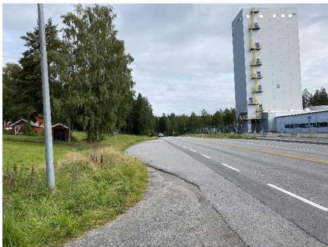
Mapei øst for Storsjøvegen (t.h.), busslomme og boligeiendom (t.v).
